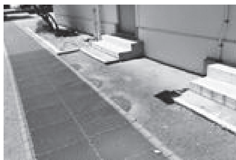
図8 校舎間移動を可能とするマットの設置
