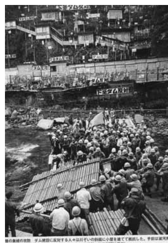
蜂の巣城の砦。ダム建設に反対する人々は川を渡る小橋を建てて監視した。手前は建設局の重機が下笠ダム建設現場の作業員を監視する様子。昭和29年5月撮影。写真新聞社提供。
