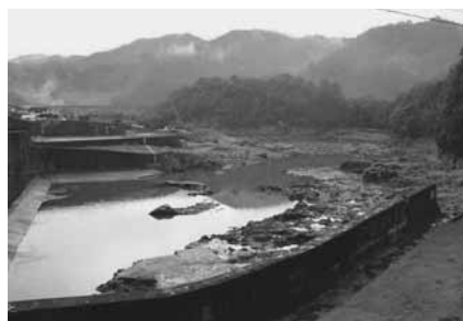
写真14 夜明ダム下流
