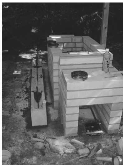
写真一 耐火煉瓦窯の焚口
