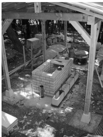
写真一 耐火煉瓦窯の煙突方向から
