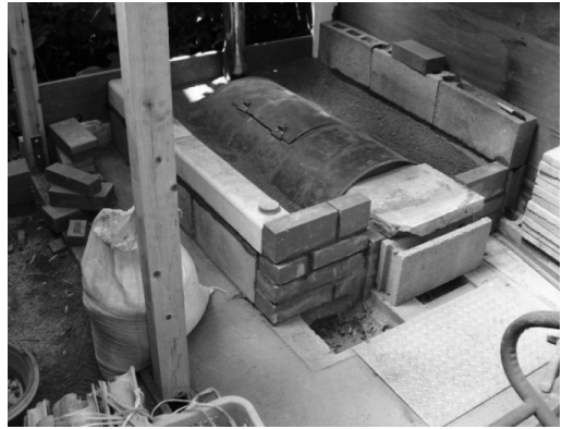
写真-2 ドラム缶窯の設置
