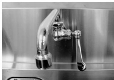
図13 シンク水道、レバー式の蛇口
