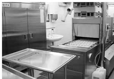
図12-3 食器洗浄室：食器洗浄機（後側）、排水管付き作業台（手前）、食器消毒保管庫（左）
